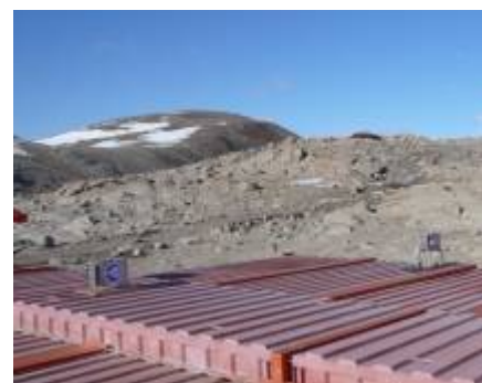
Fig. A4.1 - Disposizione dei radiometri FRAD2008-02 (a destra) e FRAD2011-04 (a sinistra) sul tetto degli edifici di OASI, a MZS.
