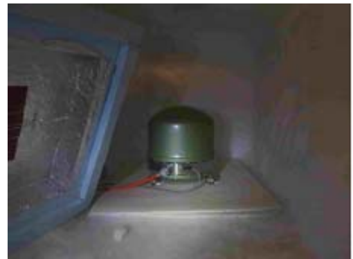
STS2, protection isotherme enlevée
