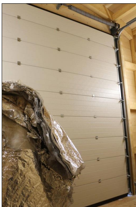
Fig. 2.2.11 - Dispositivo di apertura della serranda dello Shelter del Radiosondaggio
