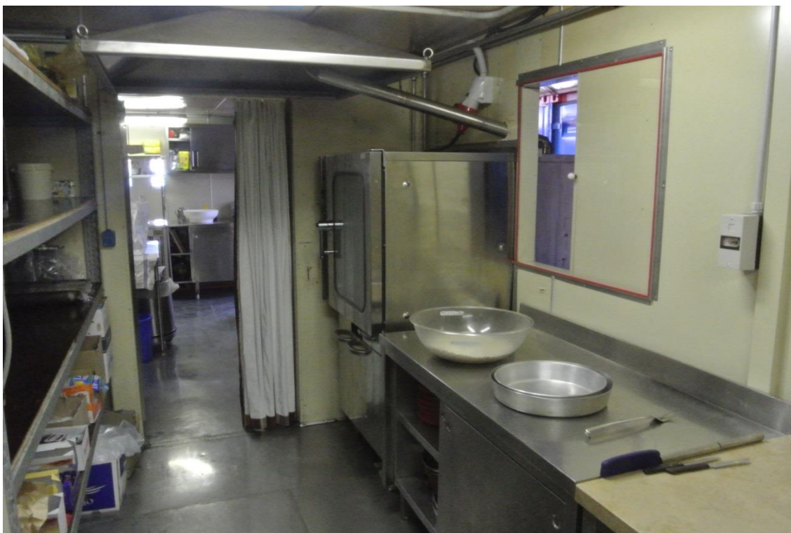
Figura 13 – Lavori di adeguamento dell'impianto di aspirazione del forno della cucina
