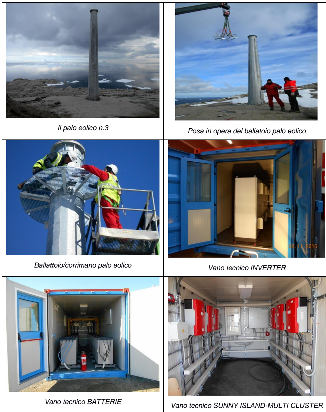
Figura 10 – Lavori di realizzazione della centrale eolica
