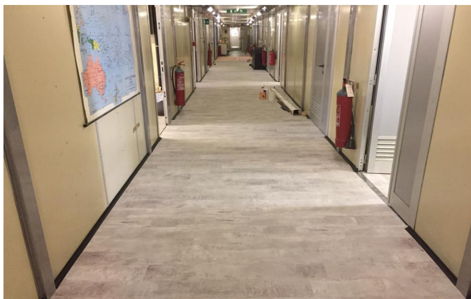
Figura 6 - Lavori di rifacimento del pavimento del corridoio centrale della zona laboratori
