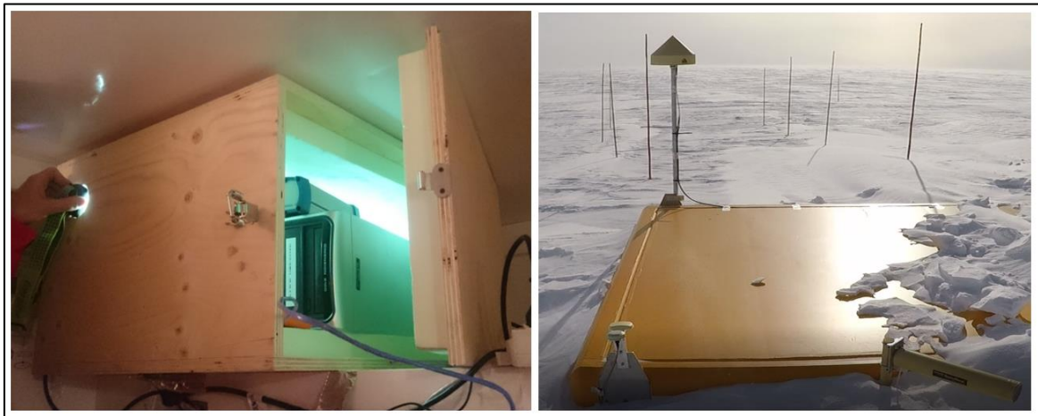
Figura 5 - Stazione di misura DMC1 e relativa antenna presso lo shelter Sismo (R.Vagni ©PNRA)
