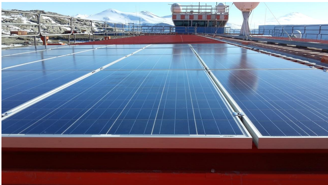
Figura 4 - Posa di moduli fotovoltaici per test meccanico sulla nuova falda
