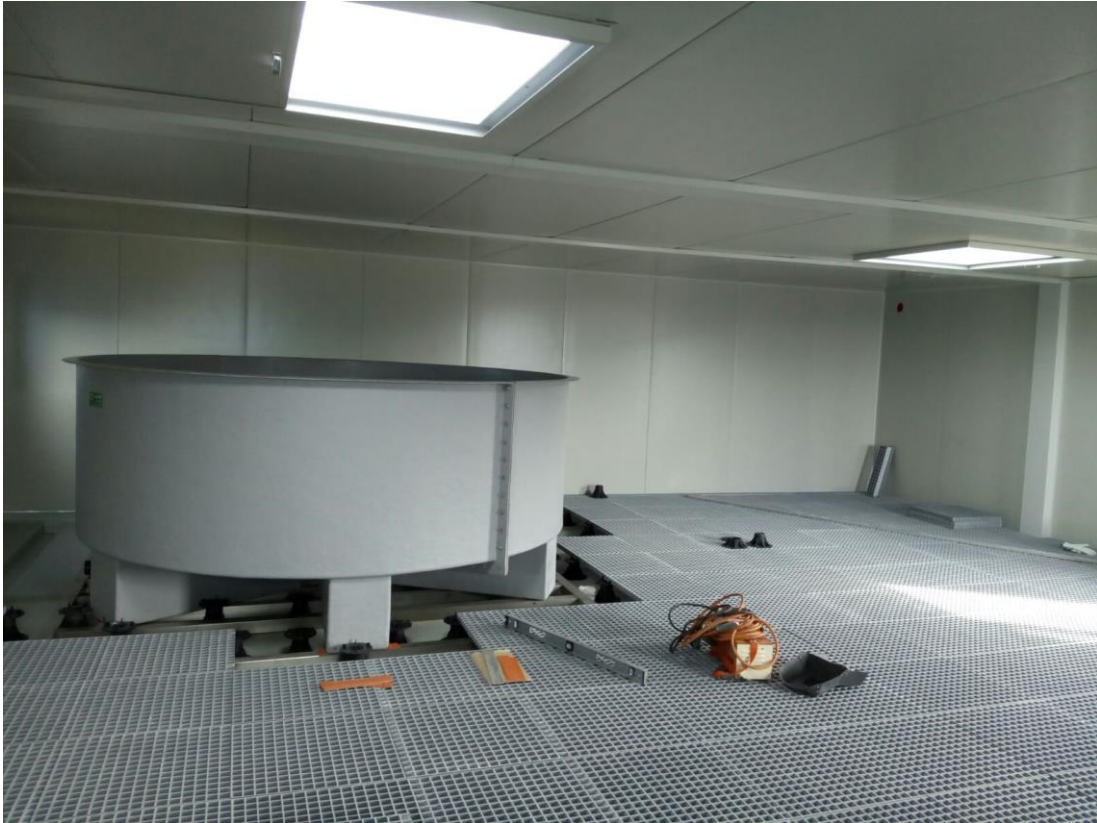
Figura 12 – Lavori di allestimento interno del laboratorio
