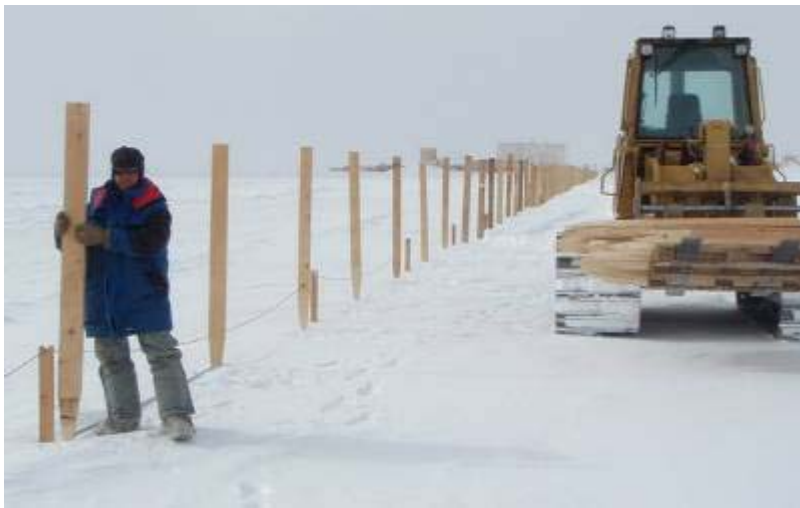
Pose des poteaux électriques vers la TOUR US
