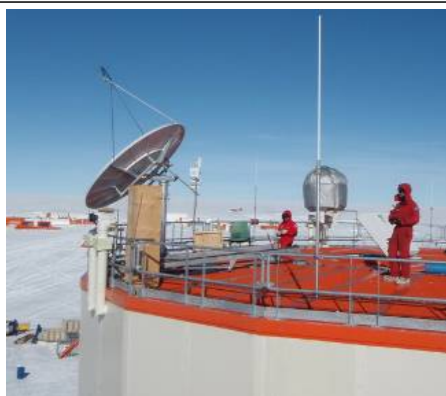
Antenne VSAT sur le toit du BC, avant son démontage
