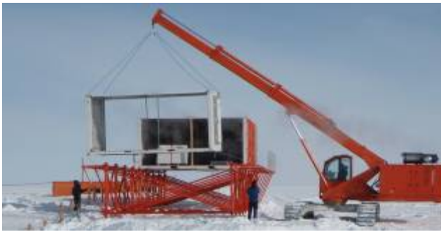
Shelter GLACIO : Mise en place des conteneurs
