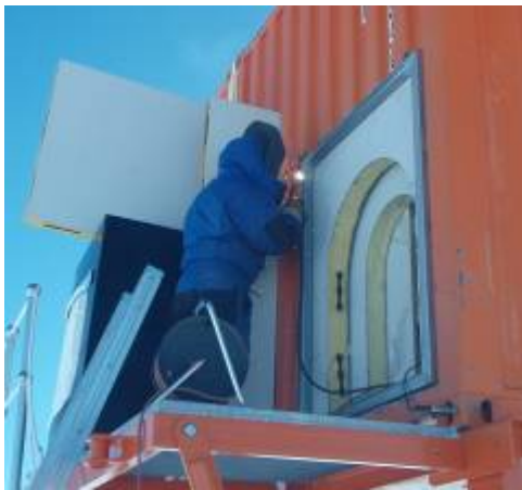
HAMSTRAD: Soudure du cadre pour la niche du radiomètre
