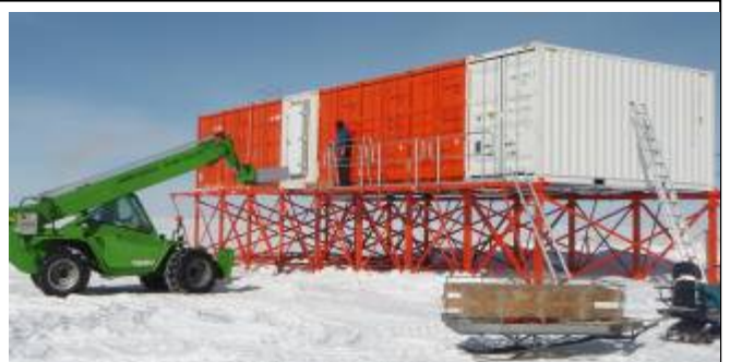
Shelter GLACIO : Etat du montage fin CE0910
