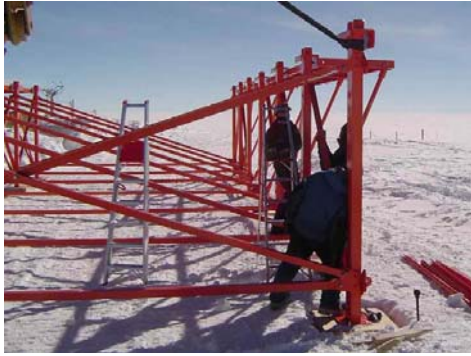
Nouveaux shelters : Assemblage des structures sur site
