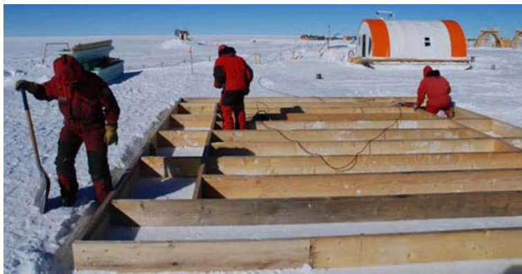
IRAIT : Fabrication du plancher isolé et →
