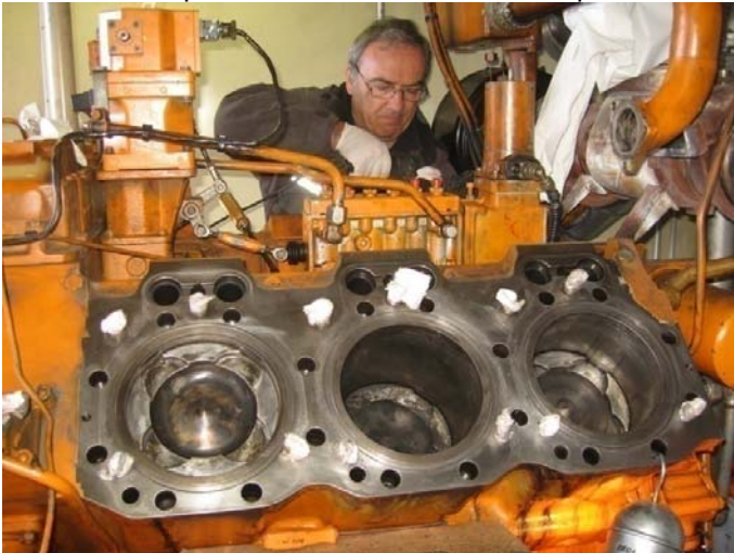
Lavori di sostituzione delle teste al gruppo Isotta n. 2
