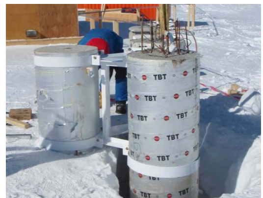
mise en place des poteaux en béton allégé
