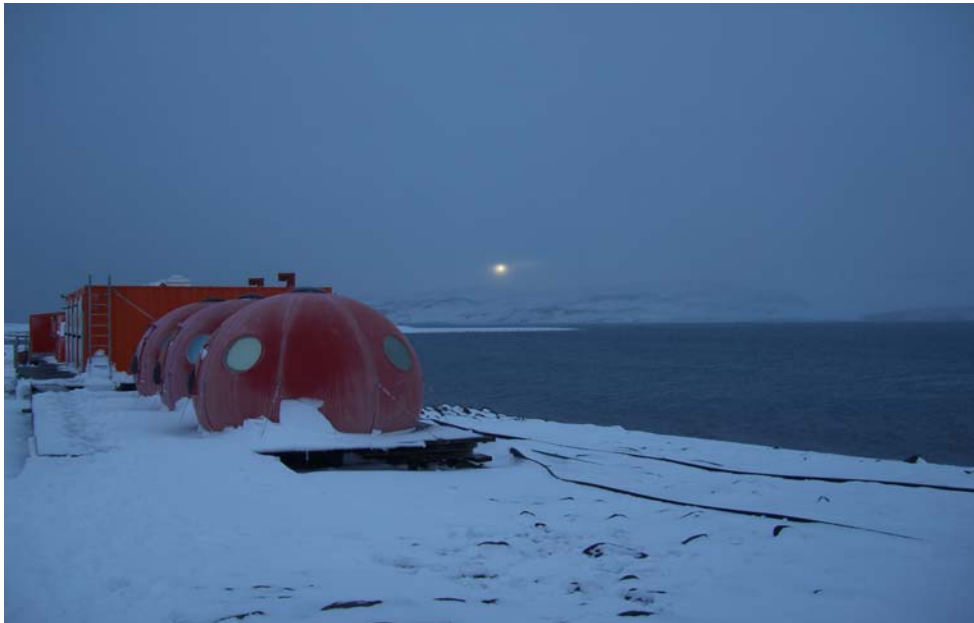
Laboratorio Dallmann: i "tomatoes", prefabbricati a scopo dormitorio, e i container laboratorio (foto C. Papetti)
