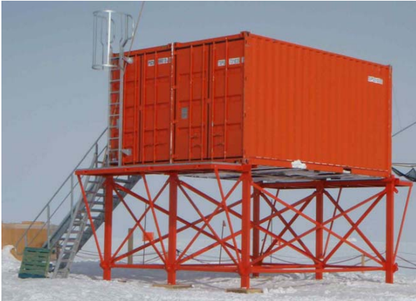
Nouveaux shelters : Shelter PHYSIQUE fini
