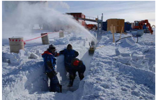
Trancher pour le tubosider pour les câbles électriques vers HF et SUPERDARN
