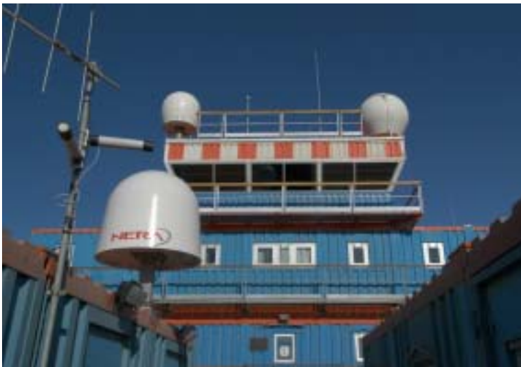
In primo piano il radome dell'antenna del nuovo Fleet 77 di RADIOS e le due antenne Wireless cilindriche che connettono, alla rete della Base MZS, PAT Motori ed il blocco Hangar-Magazzino
