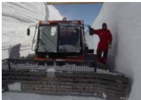
Scavo della trincea con PB330
