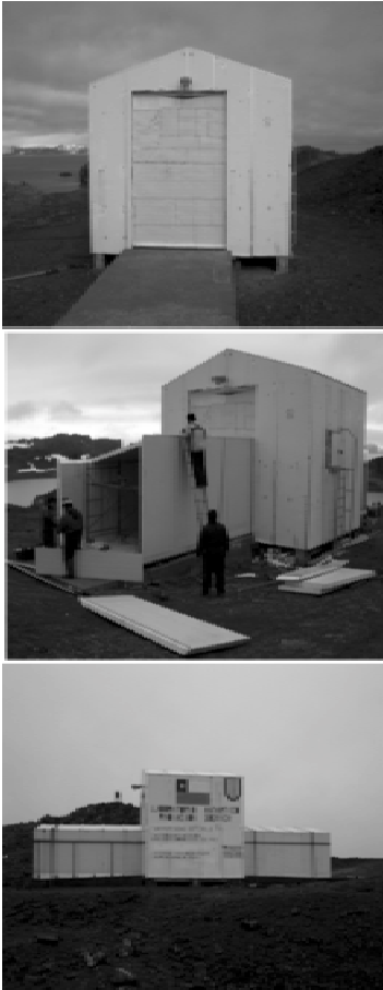
Fig. 7.6.1: A sinistra dall'alto sono rappresentate le fasi della costruzione dell'ampliamento dell'osservatorio LARC. A destra è rappresentato l'incremento del flusso di raggi cosmici dovuto all'arrivo di protoni solari relativistici del 20 gennaio 2005.
