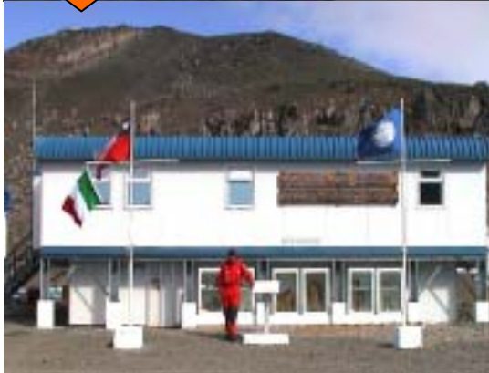
Edificio INACH – Base E. Frei (in basso) e LARC (in alto).
