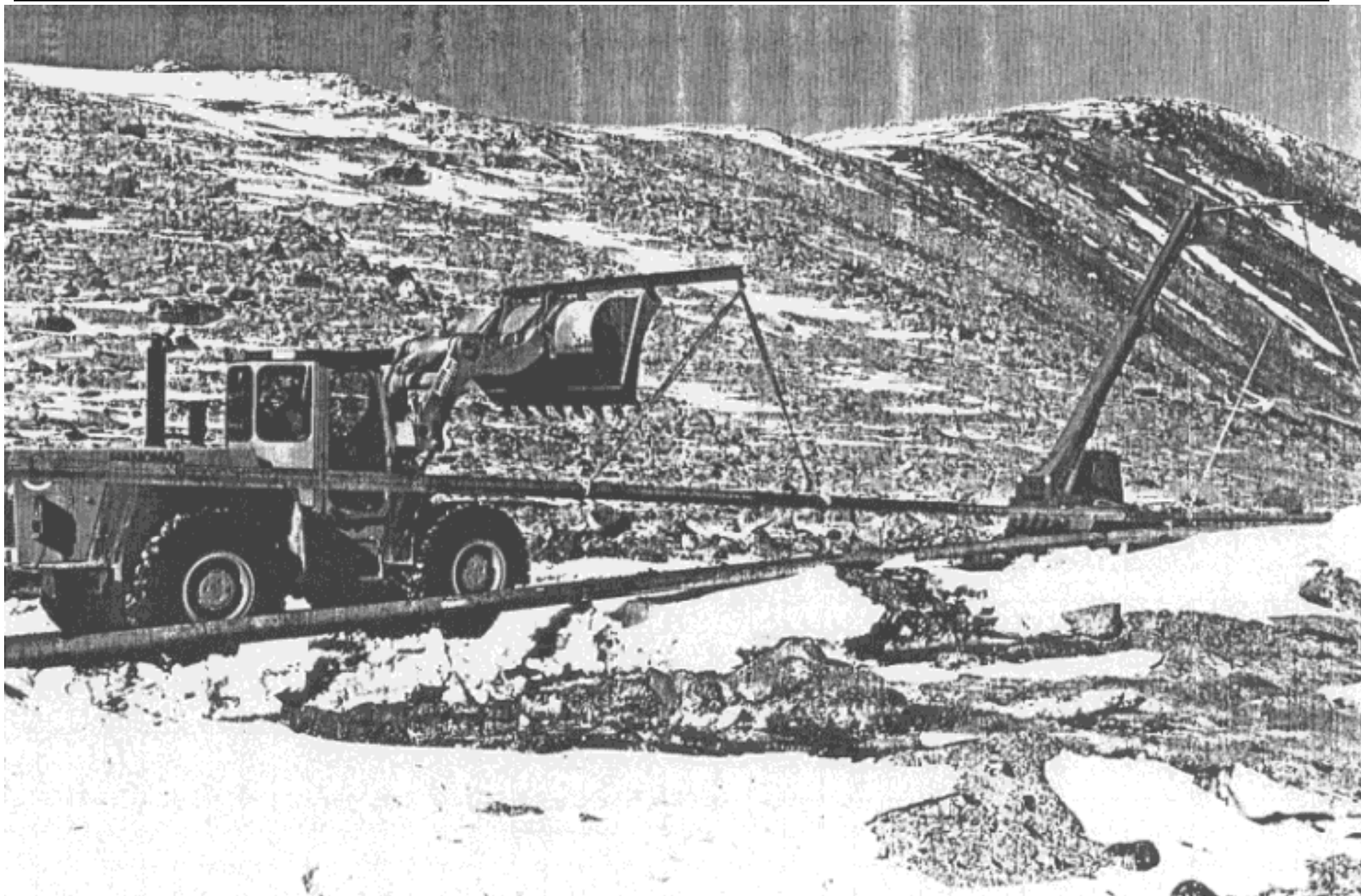
Realizzazione della condotta tra Tethys Bay e serbatoi per le operazioni di rifornimento di combustibile avio.
