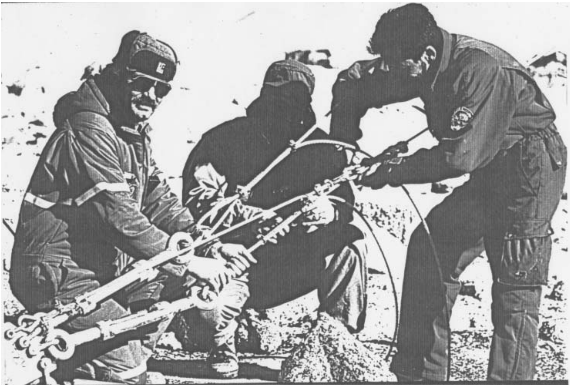
Fig.29 - Tecnici al lavoro per l'installazione dell'antenna rombica
