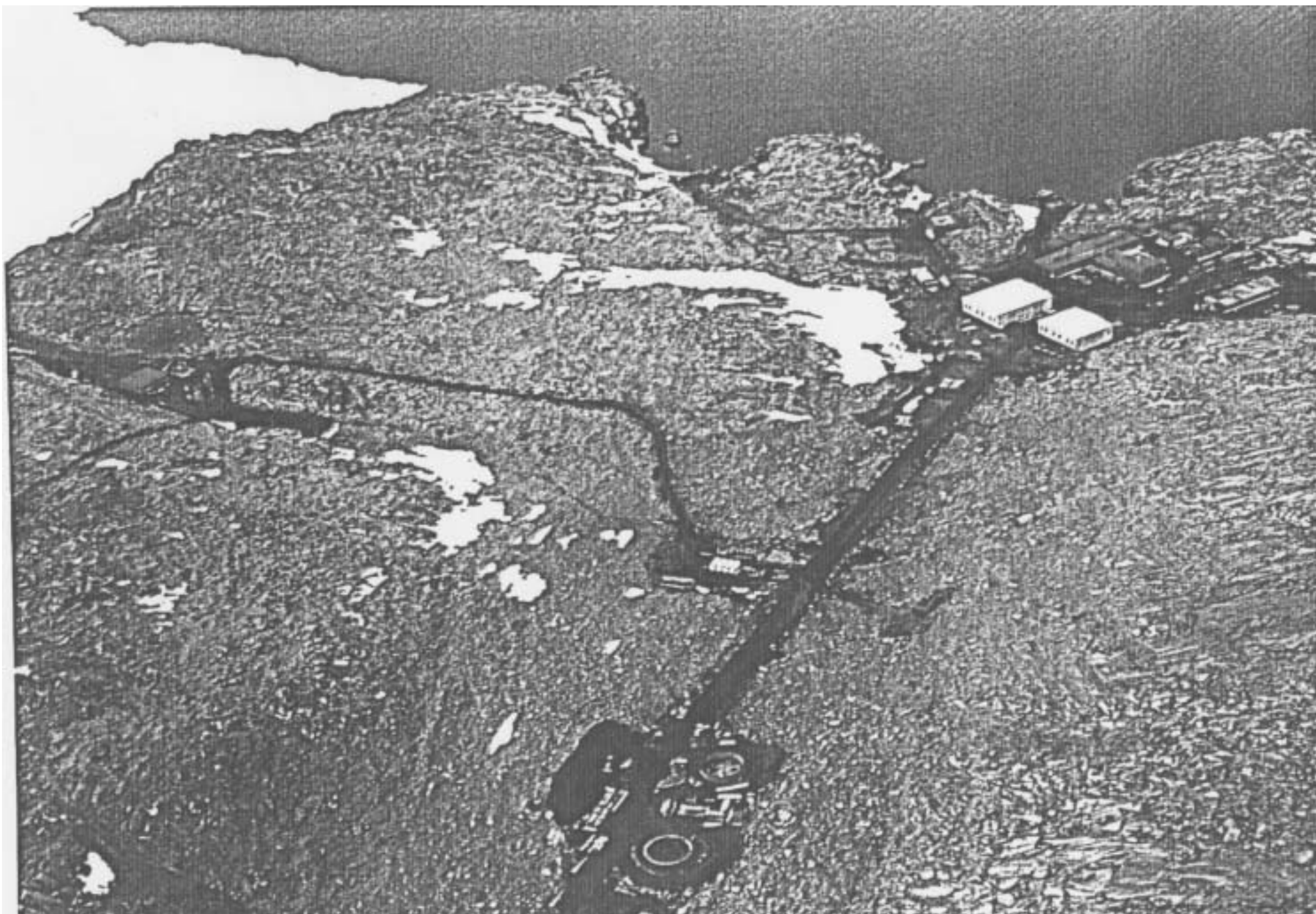
Fig.31 - Veduta aerea di Baia Terra Nova: in basso i serbatoi in costruzione, a sinistra la zona nuova OASI, a destra la Base
