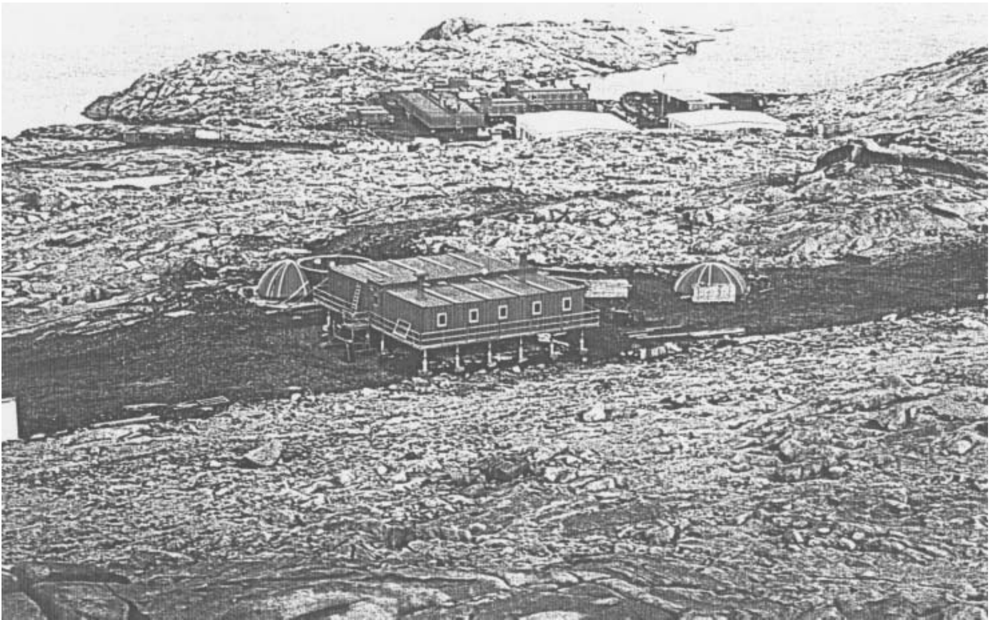
Fig.12 - Zona "nuova OASI" in primo piano, sullo sfondo la Base
